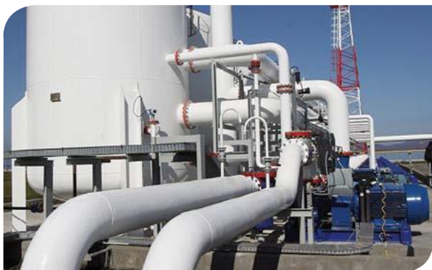
Трубопроводная система "Восточная Сибирь-Тихий океан", г. Белогорск.
