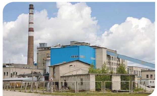
Картонная фабрика, Житомирская обл. г. Малин
