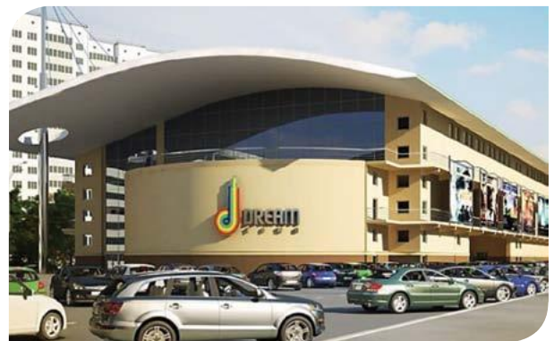
Торгово-развлекательный центр "ДримТаун", г. Киев
